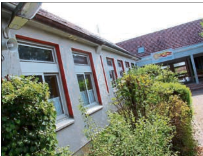
Die gesamten Fenster der Luzia-Grundschule in Oestereiden sollen in den Herbstferien durch neue ersetzt werden. ■ Foto: Mund
